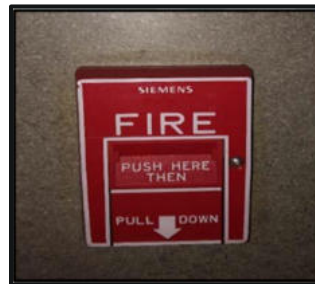
PALANCA DE INCENDIO
